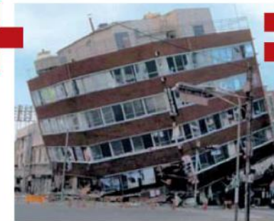
Abb. 5: Erdbebenschaden (Kobe Japan 2005). Quelle: H. Bachmann
