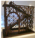
erdbebensichere Holzstruktur "gaiola pombalina"
